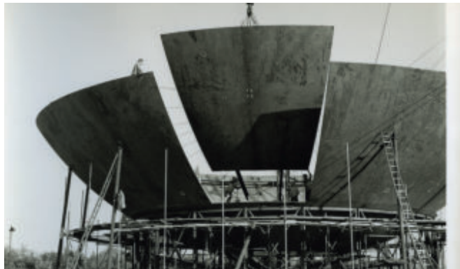
Bau der Gaskugel Freiburg, 1964/65, Foto Badisches Landesmuseum Karlsruhe, Außenstelle Südbaden / Hugo Beyer.
